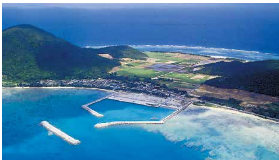
2000(平成12)～2001(平成13)年にかけて施工を担当した伊平屋漁港
