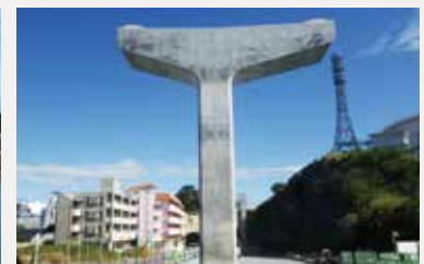
市道国際センター線都市モノレール建設工事(下部工H26-1)
