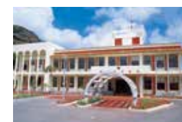
伊平屋村役場庁舎
