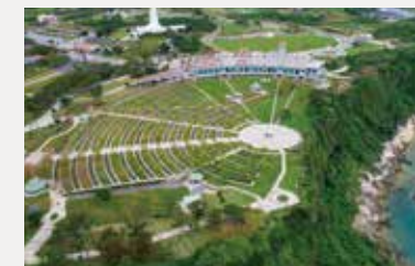
平和の礎建設工事
