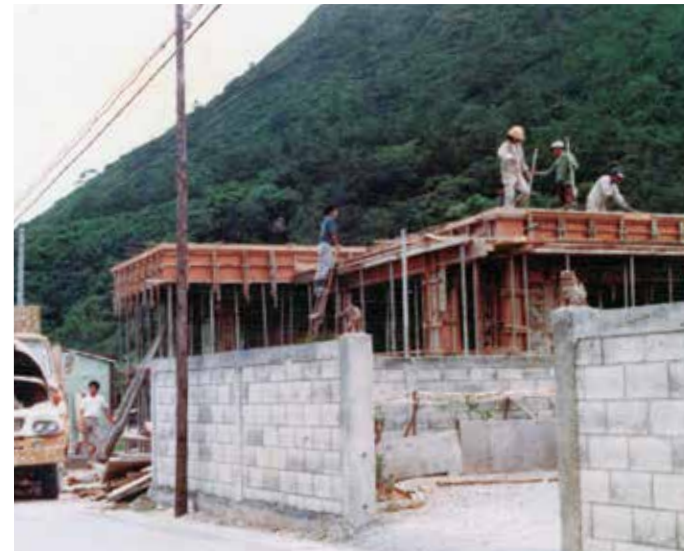
1979(昭和54)年頃の住宅新築工事の様子
