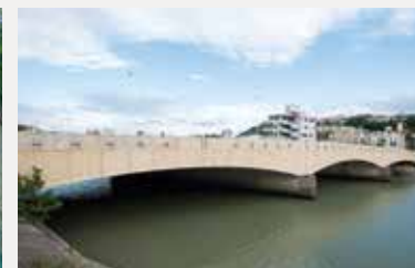
真玉橋橋梁整備工事
