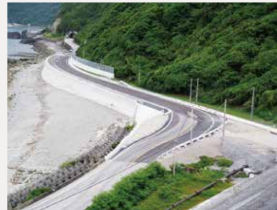
平成22年度座津武地区道路改良(その1)工事
