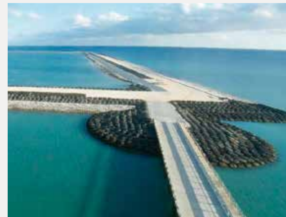
中城湾港土砂処分場Ⅰ中仕切護岸外1件築造工事
