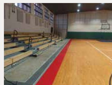
トリステーション B266 体育館改修工事
