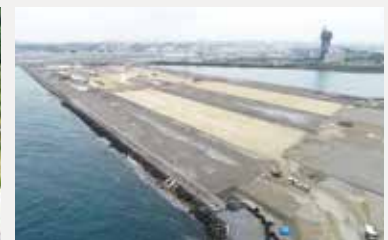
那覇空港滑走路増設5工区・6工区埋立工事
