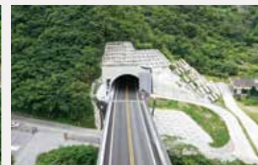
平成30年度名護東道路4号トンネル工事
