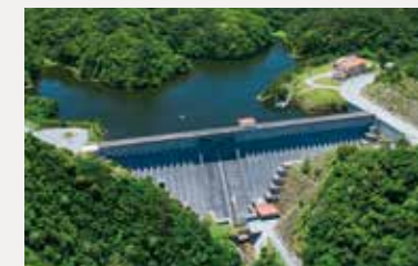
我喜屋ダム建設工事(本体)
