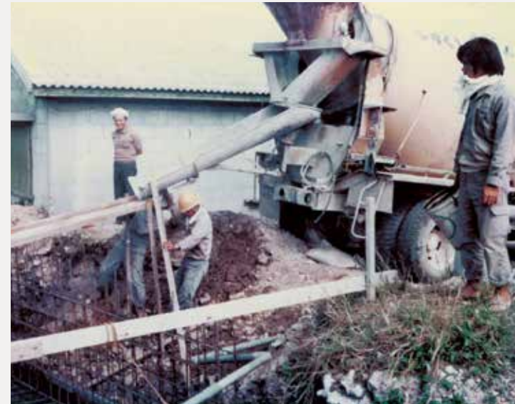
1982(昭和57)年 伊平屋村の田名地区 道路改良工事生コン 打設の様子
