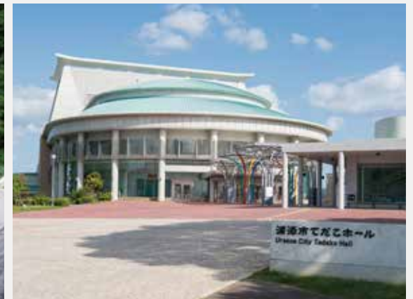
(仮称)てだこ交流文化センター建設工事(建築)
