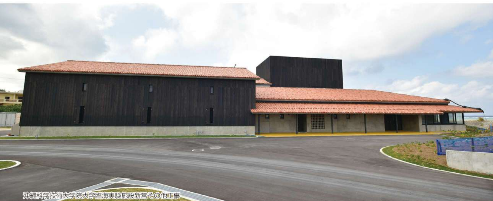
伊平屋村産業連携拠点センター建築工事
